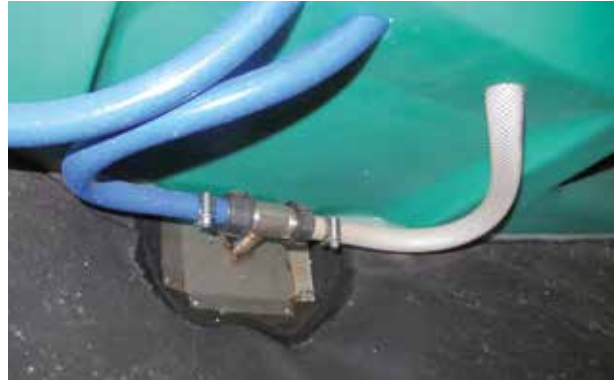
Sumpf mit Injektor TSG (ohne Luftunterstützung)
