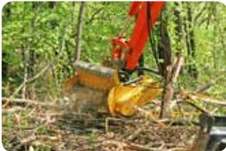
Auch bei der Vorbereitung von Baugrund werden diese Geräte gerne eingesetzt, da ein Bagger oft schon vor Ort ist. Sie beseitigen Gras, Gestrüpp und Holz, so dass die Baufläche frei wird.
